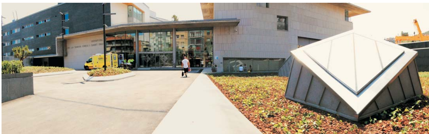
Instalación de 3 lucernarios montados sobre estructuras tronco-piramidales para iluminar los espacios subterráneos bajo la entrada principal del Nuevo Hospital Sant Pau
